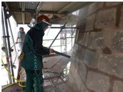
*Verfugung durch Trockenspritzen mit einer kleinen Düse, wodurch die Patina der Sandsteinoberflächen an den Fugenflanken nur wenig beeinträchtigt wird; Fertigstellung im Jahr 2015*
