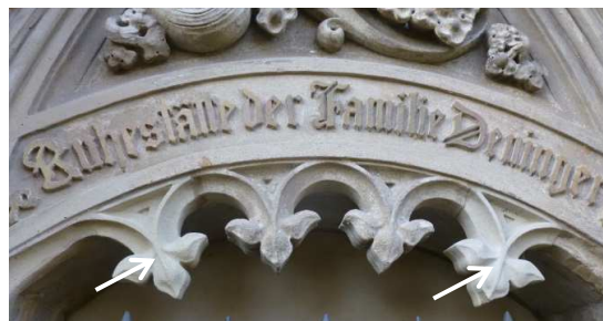
Original und Ersatz (Pfeile): Rotliegendesandstein
