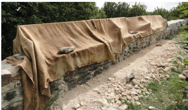
Feuchthaltung der frisch aufgemauerten Mauerkrone mittels aufgeständerter Jutebahnen
