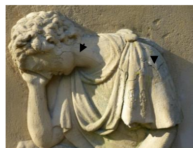
Notwendige Wartung: Schließen der Risse (Pfeile)
