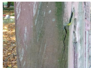
Risse entlang der Schichtung
