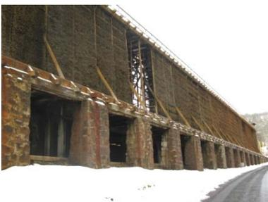
Bad Kreuznach, Gradierwerk VI im Salinental: Schädigung der gemauerten Pfeiler durch die Salze
