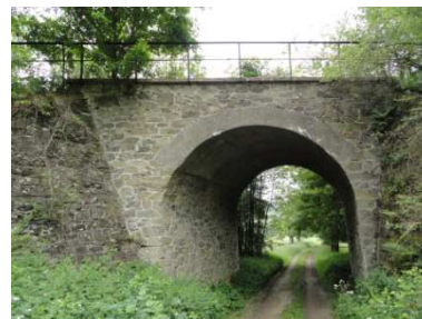
Greifenstein, Eisenbahnbrücke (Durchlass Bauernhof Keller)
