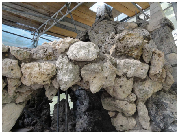
Worms, Heylshof, Grotte aus Kalktuff, Wiederaufgebaute Bogenkonstruktion mit Austauschmaterial und entwickeltem Setzmörtel. Im Hintergrund ein rekonstruierter Pfeiler.
