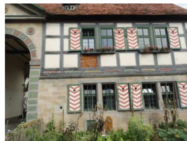
Habichtswald-Ehlen, Gut Bodenhausen
