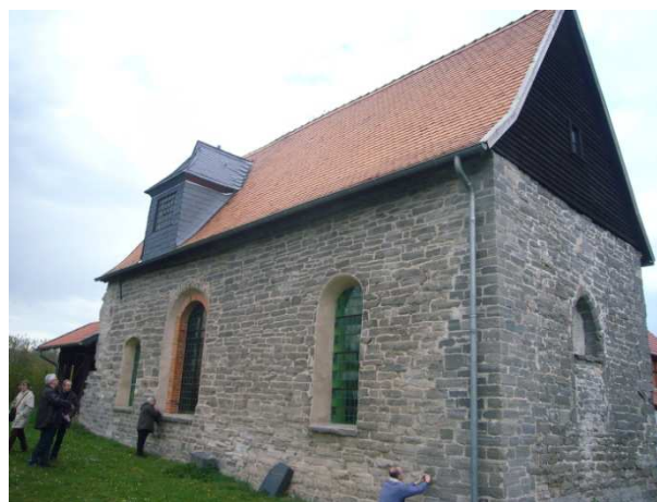
Auf der Exkursion: Kirche in Steigerthal, aus Gipsstein und Gipsmörtel errichtet
