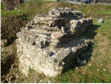
Mainz, Römisches Theater, Pfeiler Nr. 28, Vorzustand
