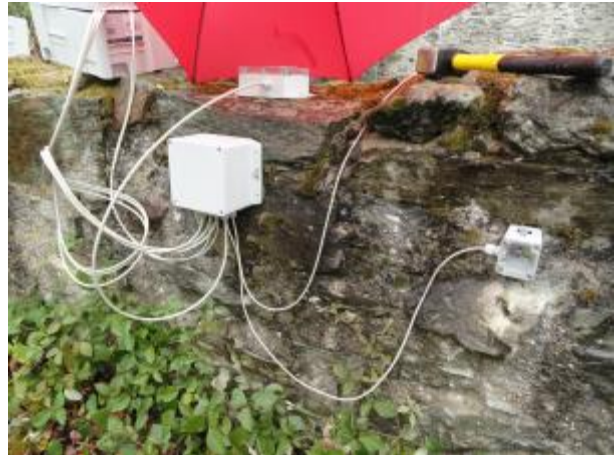
Einbau der Messsensorik an einem Mauerzug.
