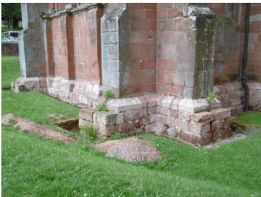
Eußerthal, Klosterkirche, Stabilisierung Fundamentmauerwerk
