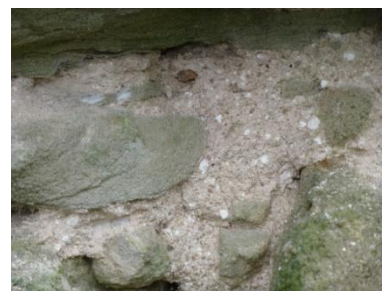
Heldburg, Ochsenmauerturm, Kalkspatzenmörtel
