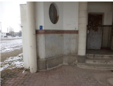
Jena, Ehem. Zementfabrik Prüssing, zweifarbigiger Terracotta-Sockel
