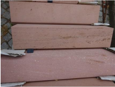
Marburg, Weidenhäuser Brücke, Austauschmaterial
